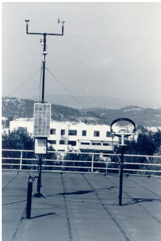
Σχήμα 11. Μετεωρολογικός σταθμός του Τ.Ε.Ι Σερρών
